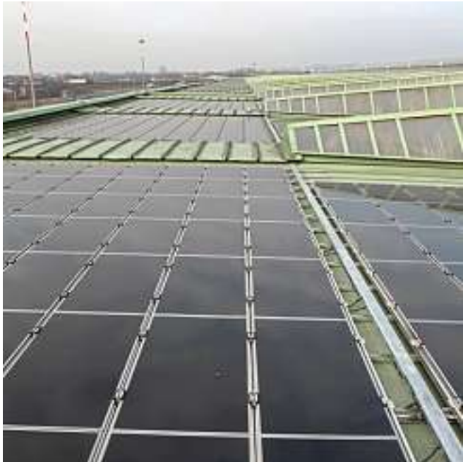
Un tetto coperto con pannelli fotovoltaici
